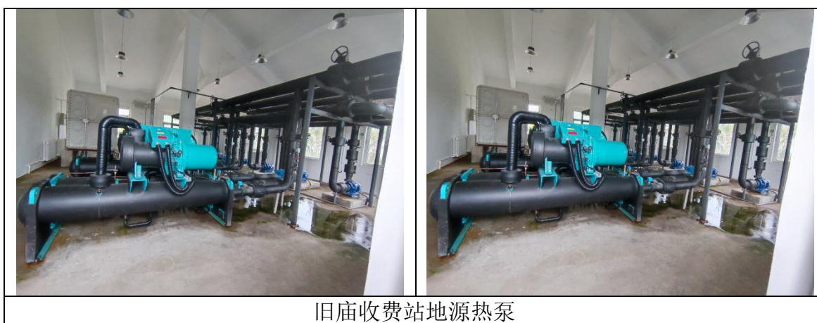
图 8.1-1 工程沿线服务设施安装地源热泵情况图
