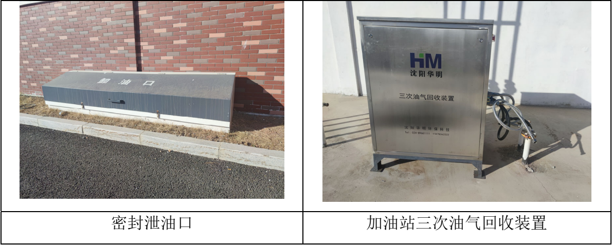
图 8.1-2 加油站油气回收措施情况图
