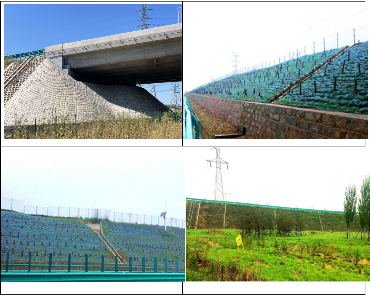
图 6.3-1 工程沿线边坡防护
